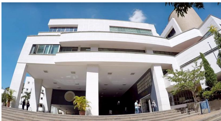
Edificio Santander, sede de la Facultad de Odontología en el campus de Floridablanca
